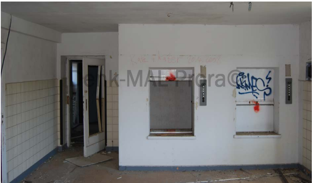
Blick nach Norden: Speiseaufzüge aus der Küche für den nördlich gelegenen Saal zwischen TH 4 und 3:
