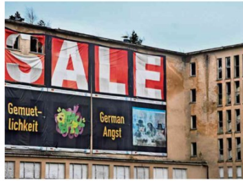
Unten: Blick auf die fast fertiggestellten Blöcke I und II. Rechts: Prora zwischen Gemütlichkeit, German Angst und dem Ausverkauf. Rechts unten: einer der beiden völlig verfallenen Blöcke im Norden, der von den Fallschirmjägern der DDR als Trainingsgelände genutzt wurde. Den südlichsten Block sprengten die Sowjets. Fotos: Simon Rilling
