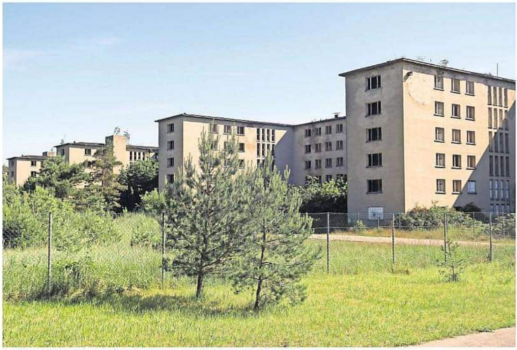
Block V: Hier soll ein geplantes Bildungszentrum neben der Jugendherberge entstehen. FOTO: STEFAN STADTHERR WOLTER
