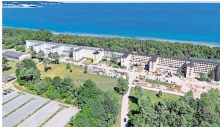
Blick auf einen Teil von Block V des Kolosses von Prora: Im linken Bereich – gleich neben dem bereits für die Jugendherberge sanierten Areal (in Weiß) – soll das neue Bildungs- und Dokumentationszentrum entstehen.
