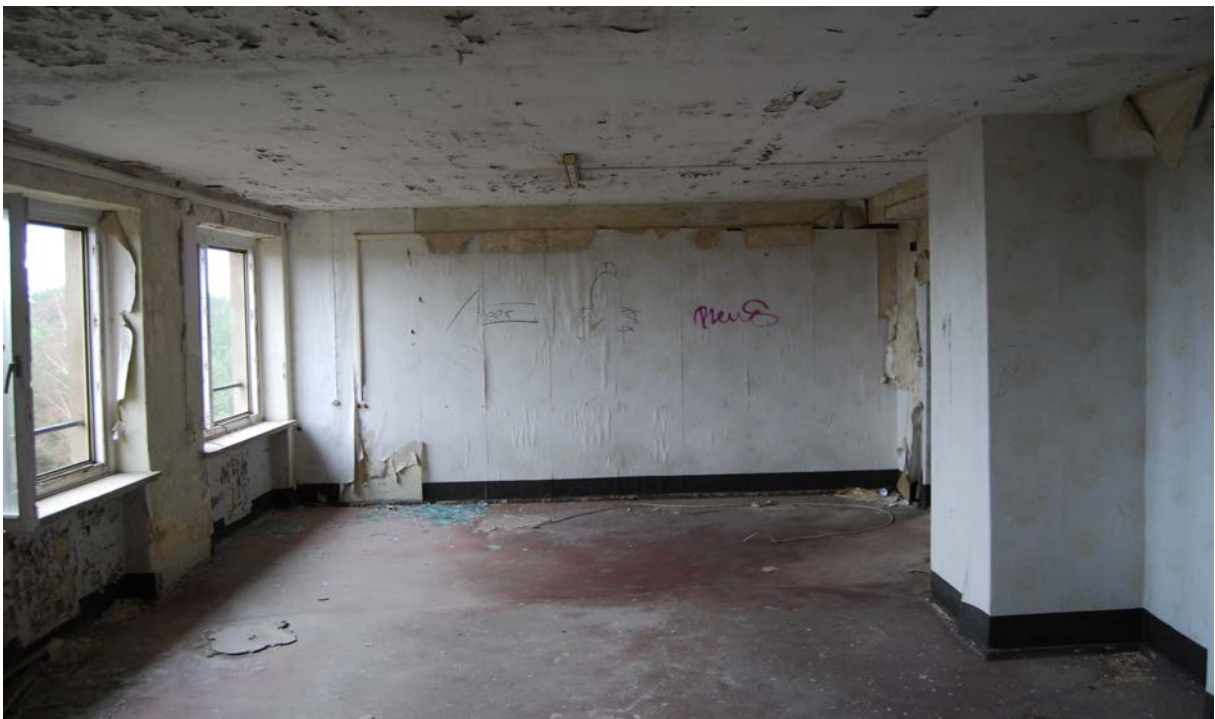
Ein interessantes Zimmer in Höhe Lichthof 6 (meerseitig):
