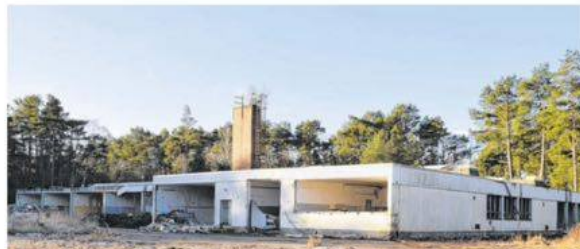
Die frühere Schule an der Poststraße steht seit vielen Jahren leer und soll jetzt abgerissen werden. FOTO: MARIO FROST
