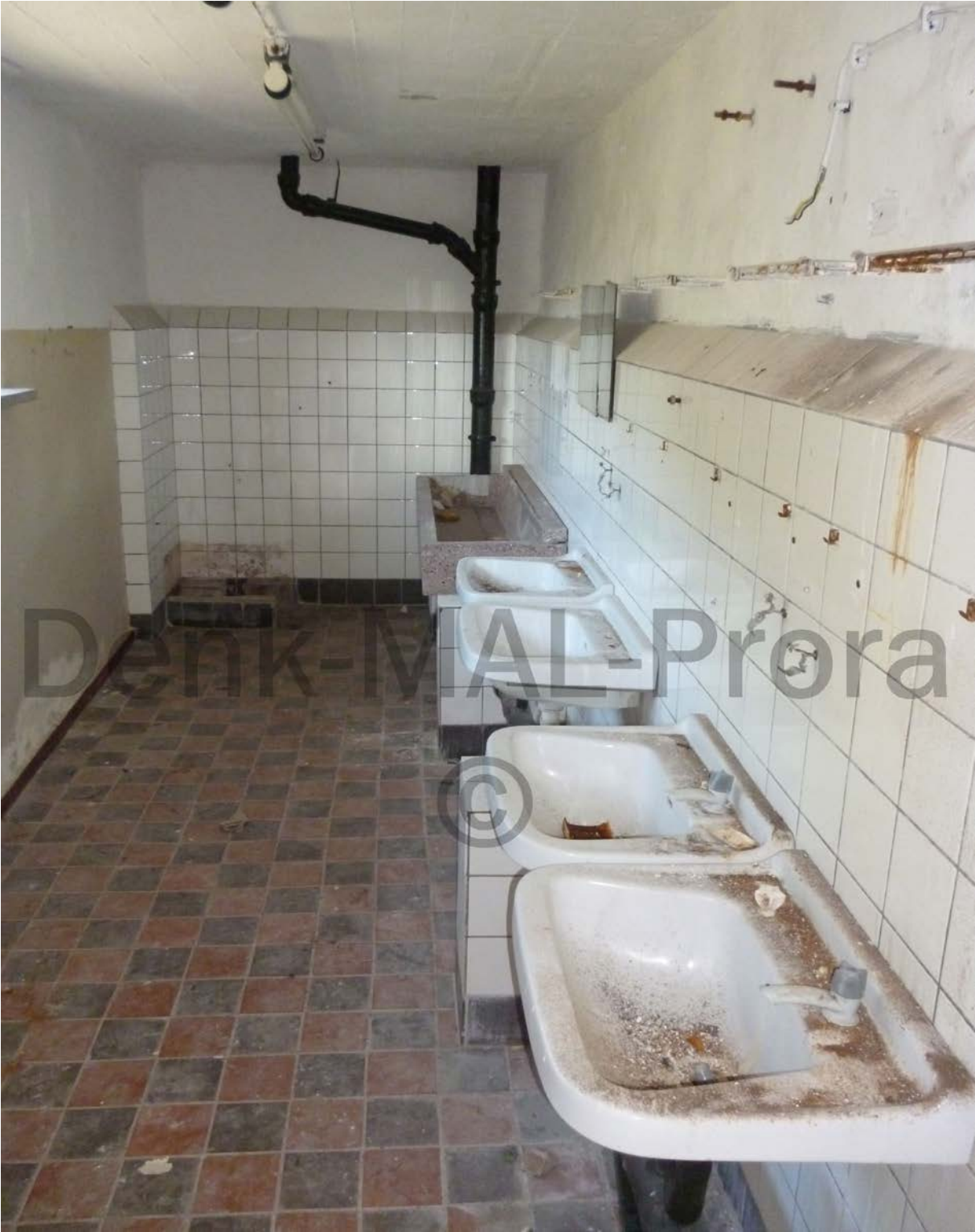
Blick in den Waschraum 2. OG Haus Flora:
