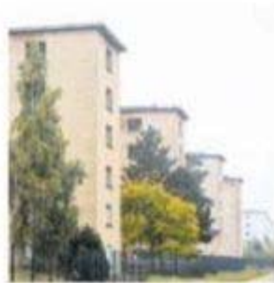
Block 5 des denkmalgeschützten Komplexes Prora. FOTO: STEFAN SAUER
