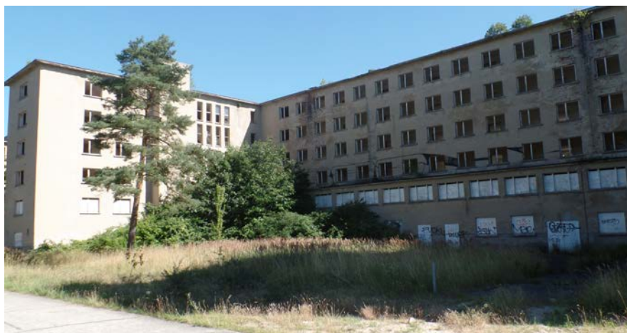
Mahnmal: Die letzte in öffentlicher Hand verbliebene Kasernenruine (in die Denkmalliste als „ehemaliges KdF-Bad“ eingetragen) wird durch den Baumbewuchs zerstört. Ein Bildungszentrum kommt nicht zustande.
