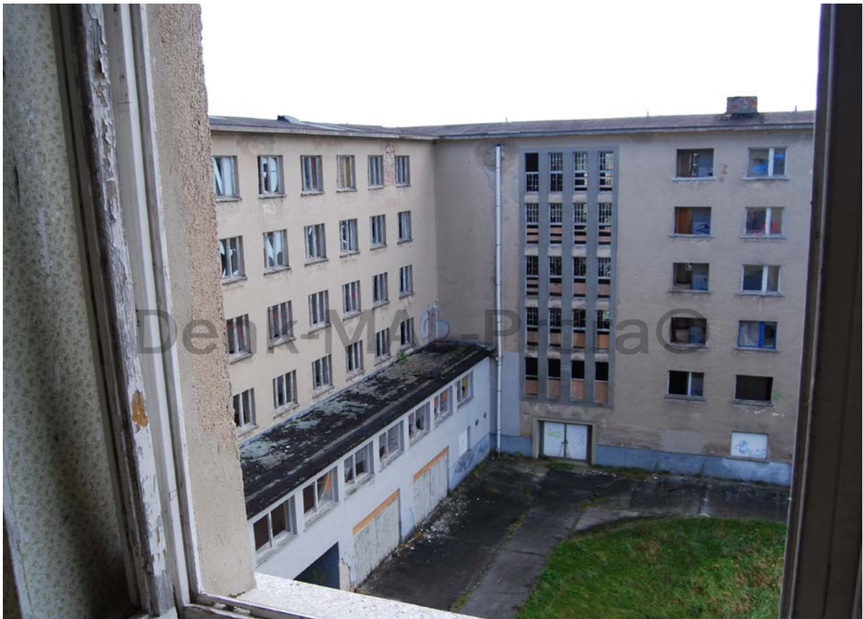
Blick in Lichthof 6 (heutiges Haus 19 ) aus dem Sanitärbereich (s.u.):
