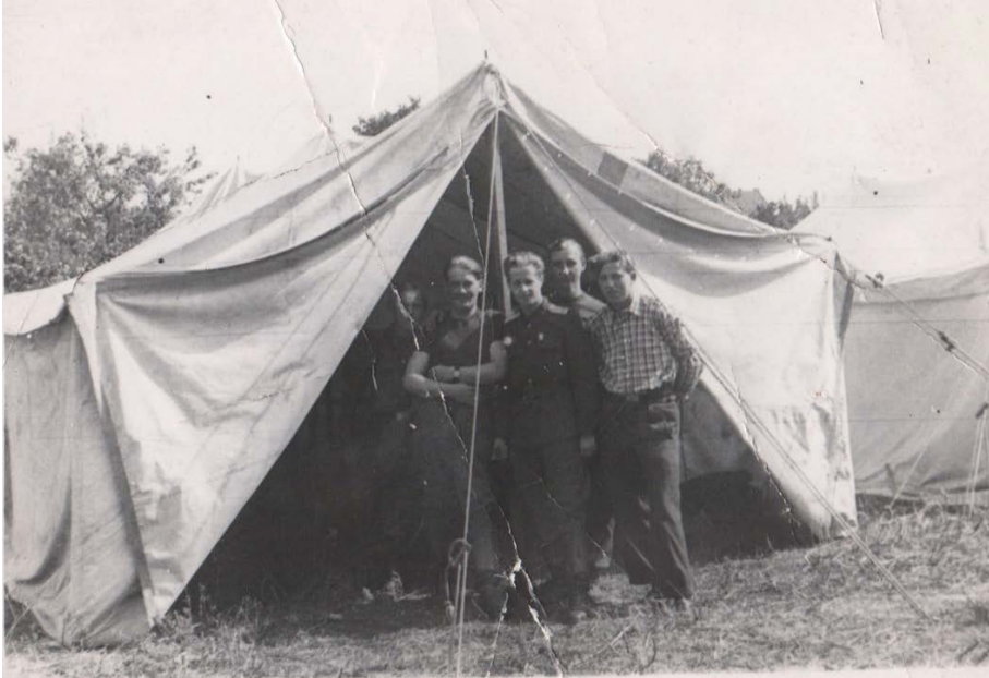
Während des Aufbaus der Kasernenanlage Prora 1952
