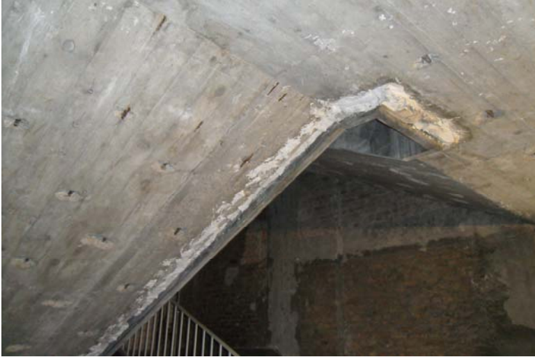
Rohbau des „KdF-Bades“ ?
